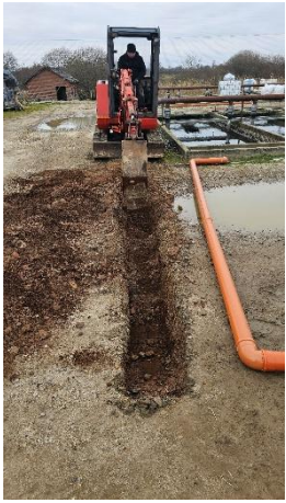
Der nedgraves drænrør for at kunne forbinde datakabler til Pacific placeret i container 1.
